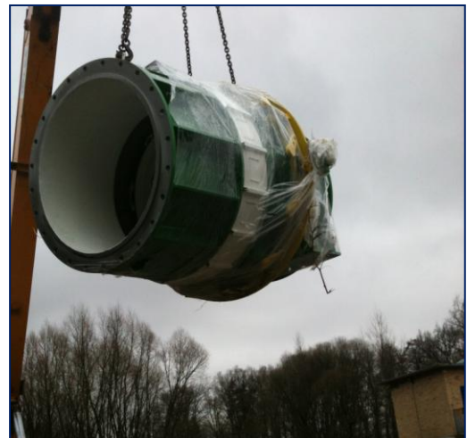
Ryc.2 Turbina podczas instalacji na lokalizacji.
